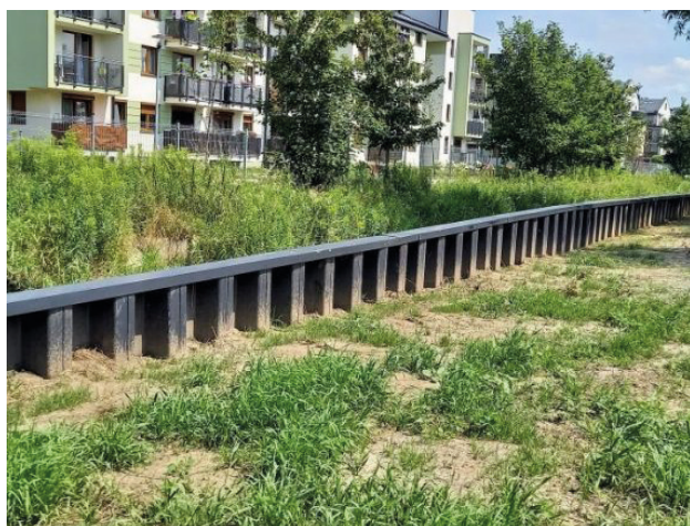
Grodzice EcoLock GW-610/9 użyte do zabezpieczenia prawego brzegu Serafy na osiedlu Złocień, fot. Pietrucha Int.
