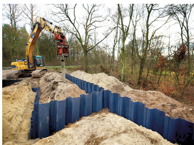
Montaż grodzic winylowych, fot. Pietrucha Int.
