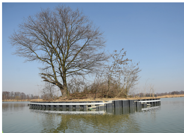
Umocniona wyspa na stawach w Malcu, fot. J. Betleja
