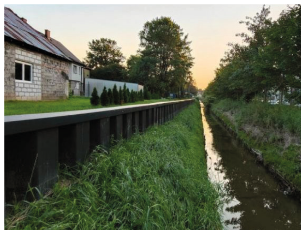
Grodzice EcoLock GW-610/9 użyte do zabezpieczenia prawego brzegu Serafy na osiedlu Złocień, fot. Pietrucha Int.
