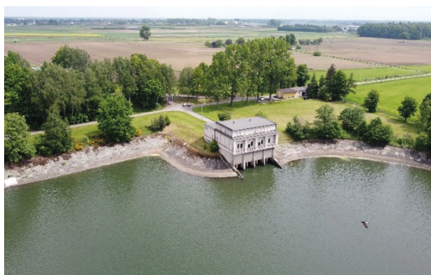
Ujęcie brzegowe dla ZUW Goczałkowice w Łące, fot. A.Siudy
