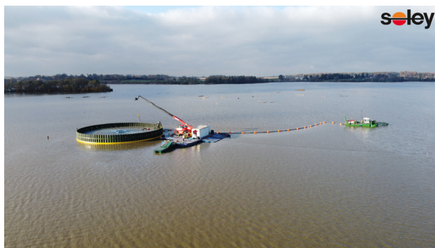
Wypełnianie korpusu wyspy materiałem z refulowania
