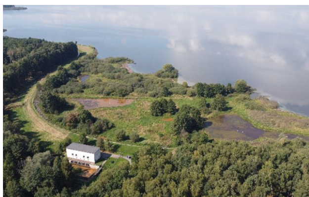
Przepompownia Zarzecze, fot. A.Siudy
