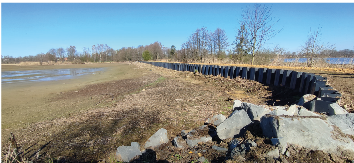
Wyremontowany fragment grobli na stawie Borek, fot. D. Czechowski
