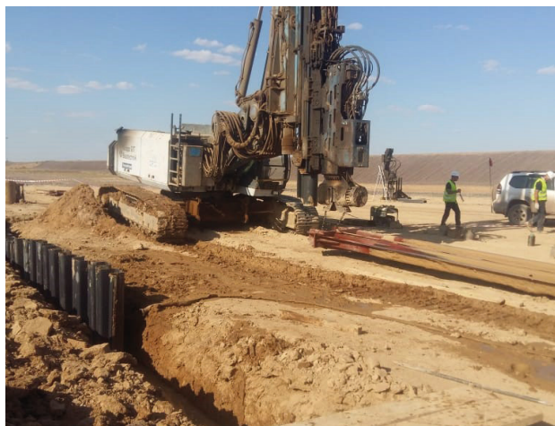
Poprawnie zamontowane grodzice winylowe na projekcie w Kazachstanie, fot. Pietrucha Int.
