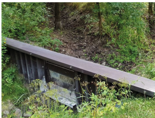
Zastawka winylowa EcoLock zamontowana w 2017 roku w Podaninie, fot. Pietrucha Int.
