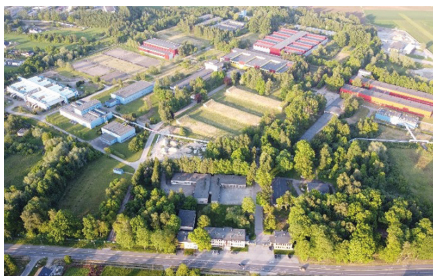
Zakład Uzdatniania Wody w Goczałkowicach, fot. A.Siudy
